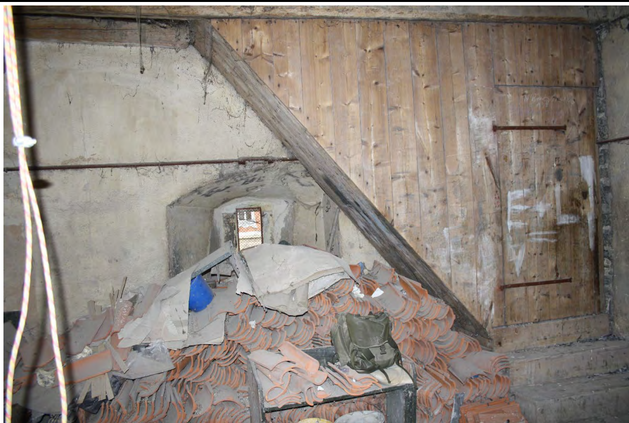
Západní strana prvního patra věže v pohledu od východu. Foto: Jaroslav Skopec, 2013.
