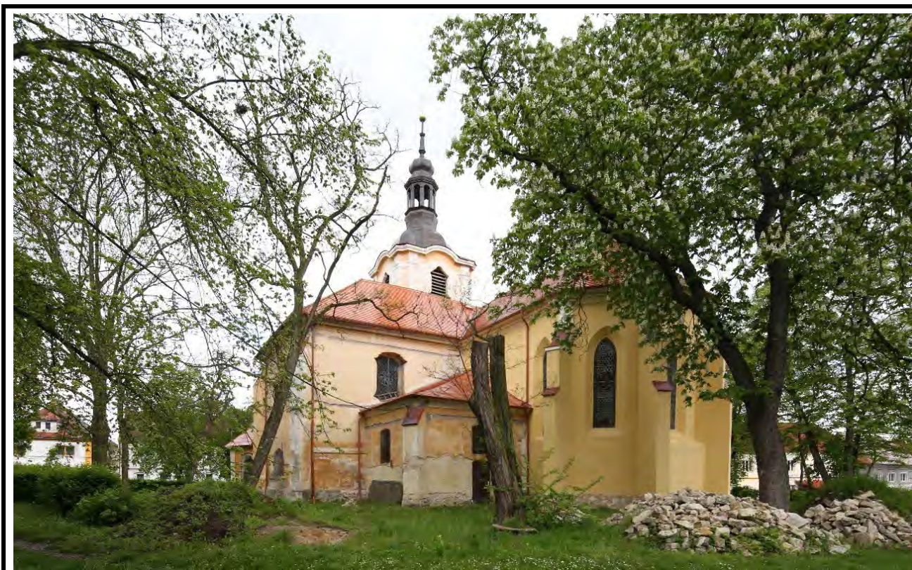
Celkový pohled od jihovýchodu. Foto: Marta Pavlíková, 2021.
