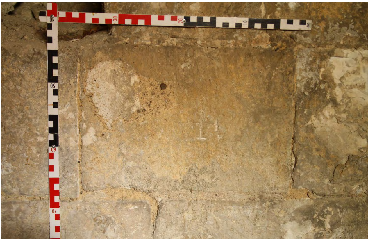
Detail kamenické značky ve tvaru zkřížených písmen „T“ na románském kvádru druhotně použitém ve zdivu věže. Foto: Jaroslav Skopec, 2014.
