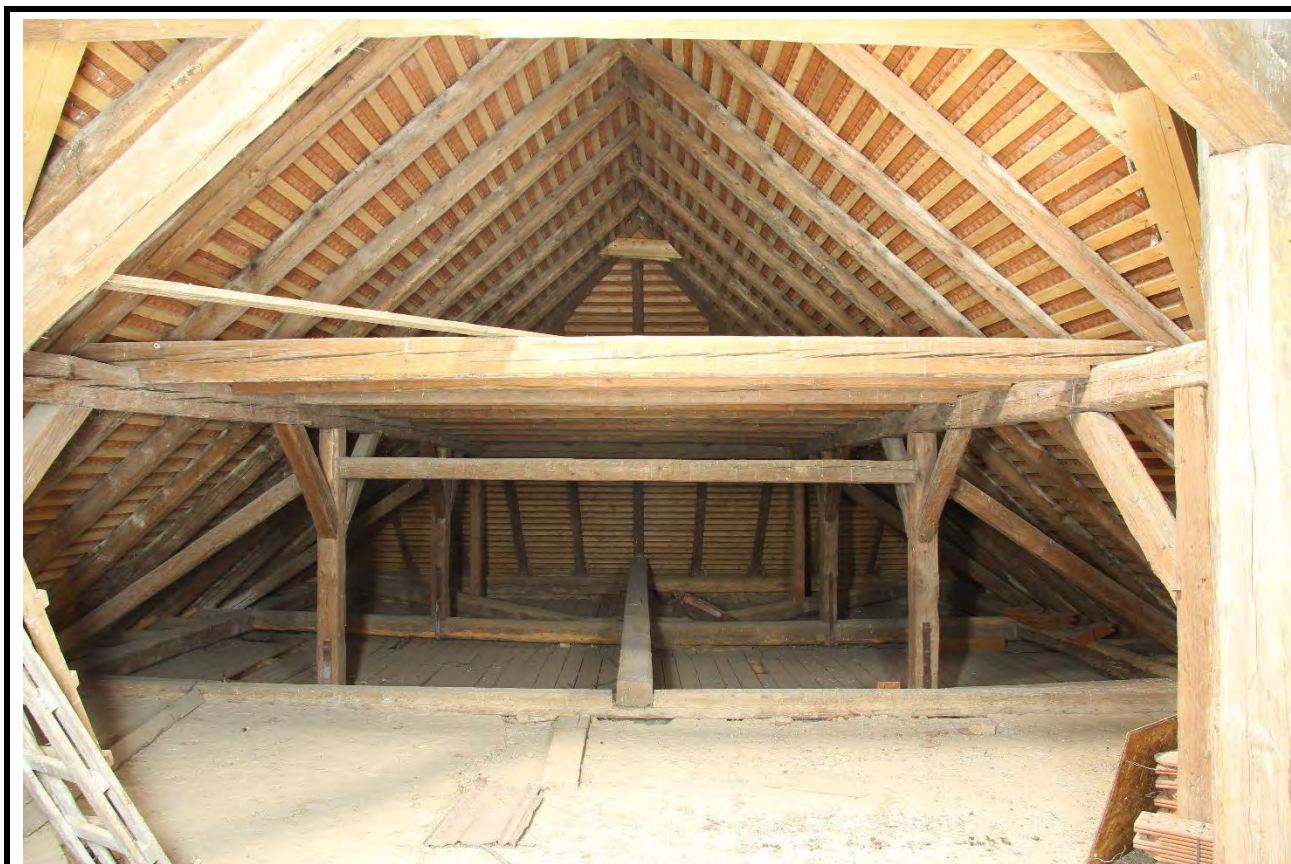
Krov nad Mariánskou kaplí v pohledu od severu. Foto: Jaroslav Skopec, 2019.
