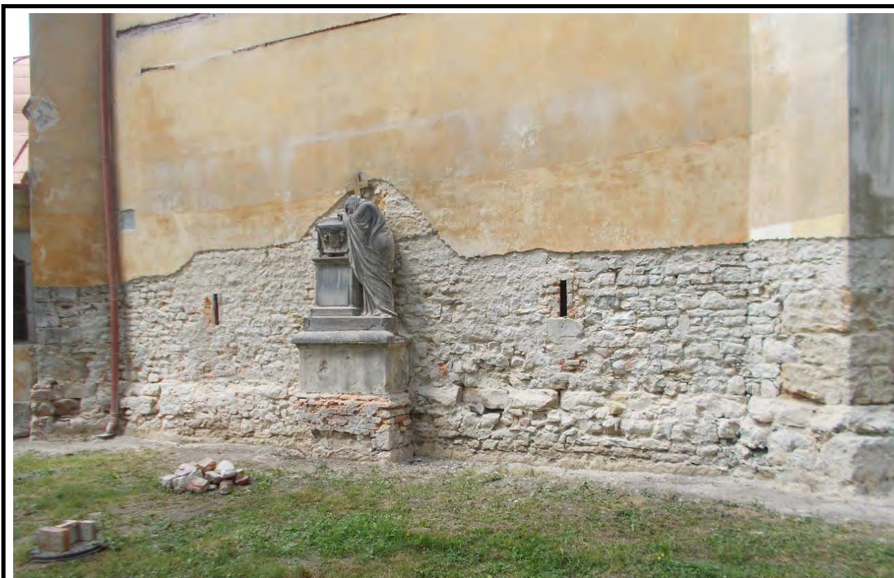
Spodní úroveň jižního průčelí Mariánské kaple po odstranění omítek. Foto: stavba, 2021.
