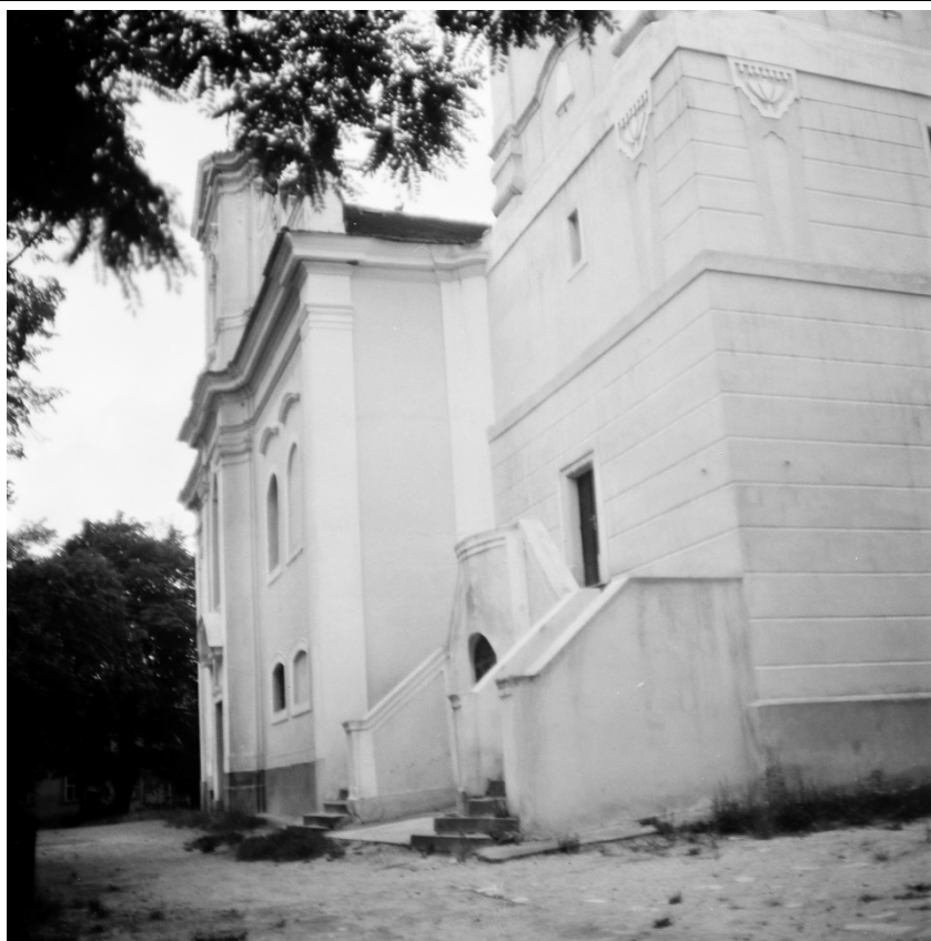
Severní průčelí lodi v pohledu od severozápadu. Foto: 1976, sbírka negativů NPÚ ÚOP v Ústí n. L., sign. 57771.
