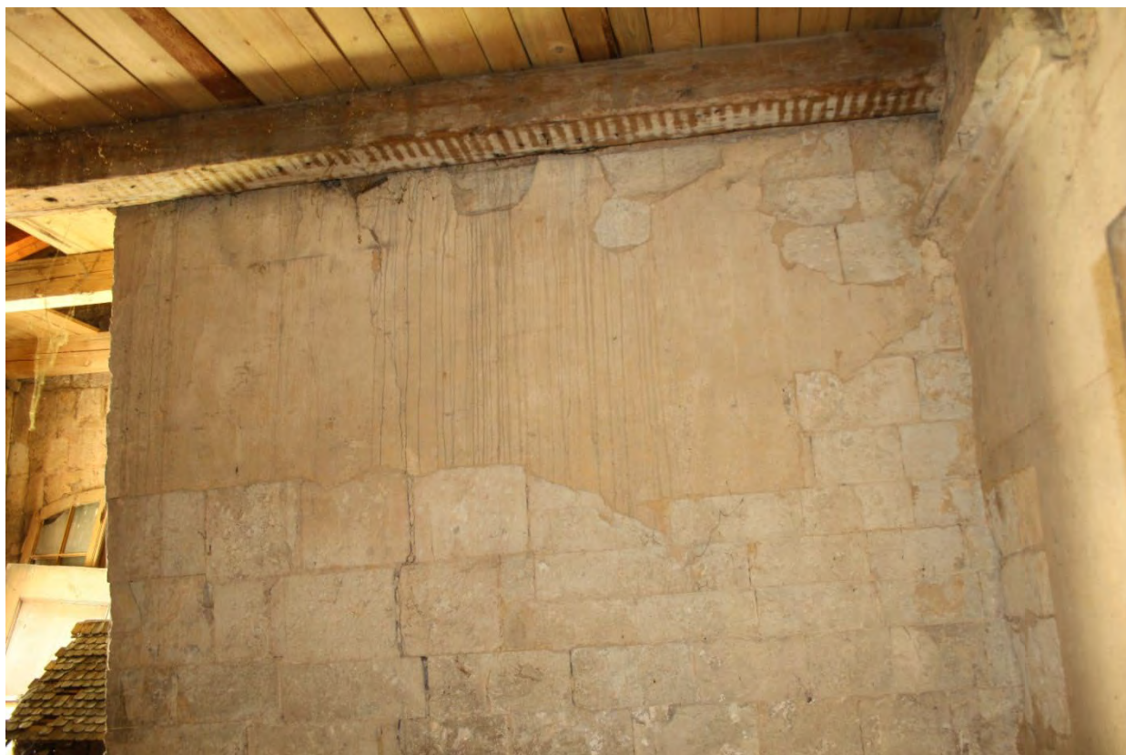
Čelní pohled od jihu na horní část lícové plochy jižní románské zdi lodi při jejím jihozápadním nároží. Foto: Jaroslav Skopec, 2014.
