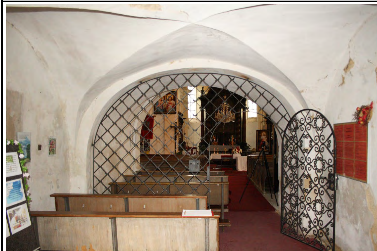
Východní strana přízemí věže v pohledu od západu. Foto: Marta Pavlíková, 2021.
