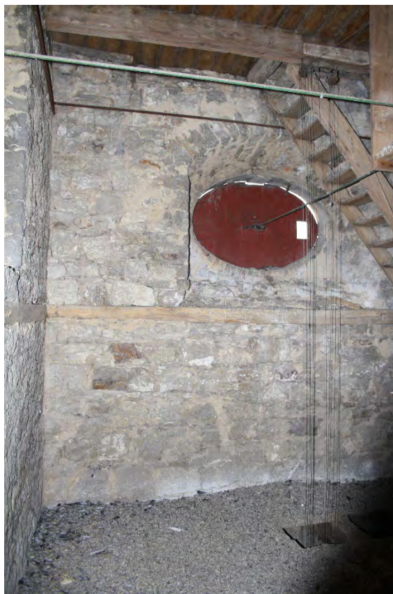
Severní strana třetího patra věže v pohledu od jihovýchodu. Foto: Jaroslav Skopec, 2019.
