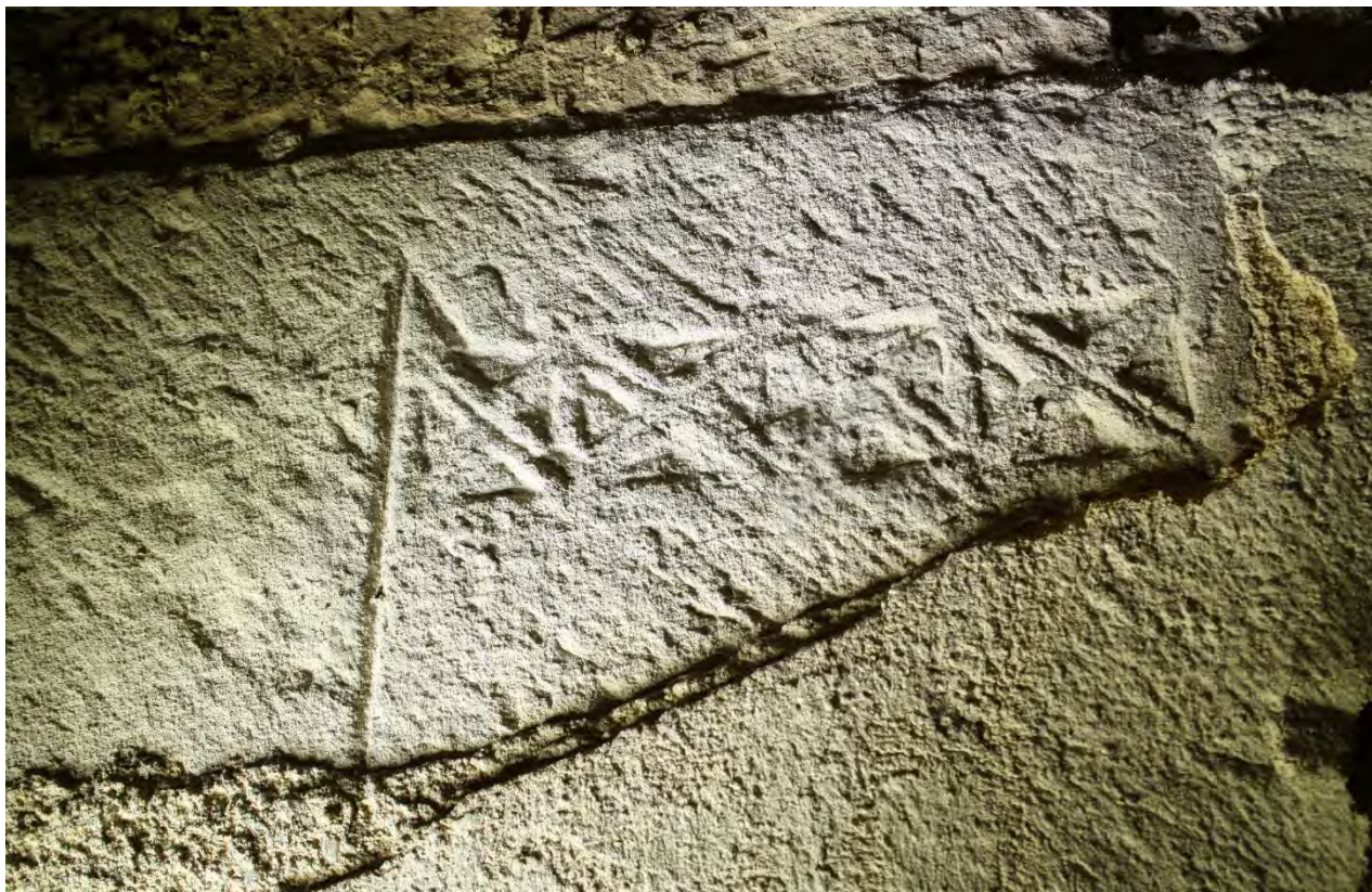
Románský kvádr s kamenickou značkou ve tvaru šipky a diamantováním, který je osazen v horní části jižní zdi lodi při jihozápadním nároží. Foto: Jaroslav Skopec, 2014.
