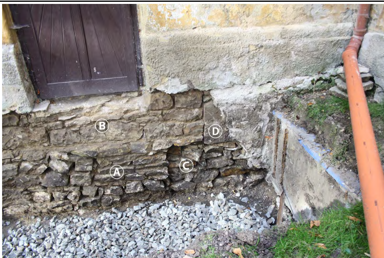
Severní konec východního zdiva sakristie v pohledu od jihovýchodu s patrným odhaleným základovým zdivem. A – Předzáklad východního zdiva sakristie. B – Východní zdivo sakristie. C – Předzáklad jižního opěrného pilíře presbytáře. D – Kvádr armování opěráku. Foto: Jaroslav Skopec, 2017.
