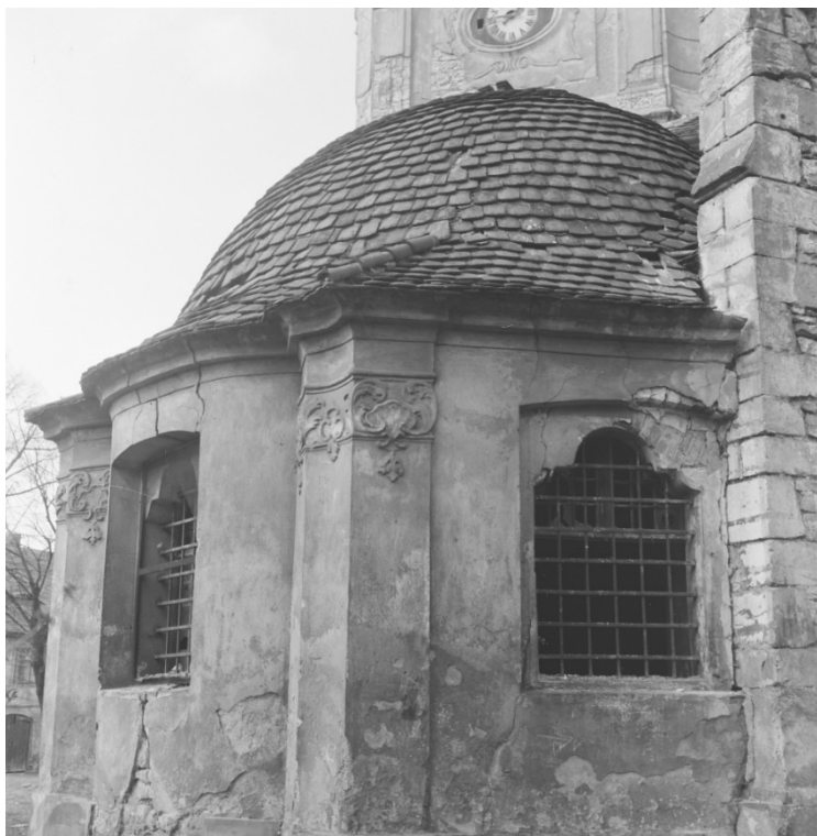
Pohřební kaple v pohledu od severu. Na pravém okraji snímku je patrné armování jihozápadního opěrného pilíře Mariánské kaple. Foto: 1967, sbírka negativů NPÚ ÚOP v Ústí n. L., sign. 27640.
