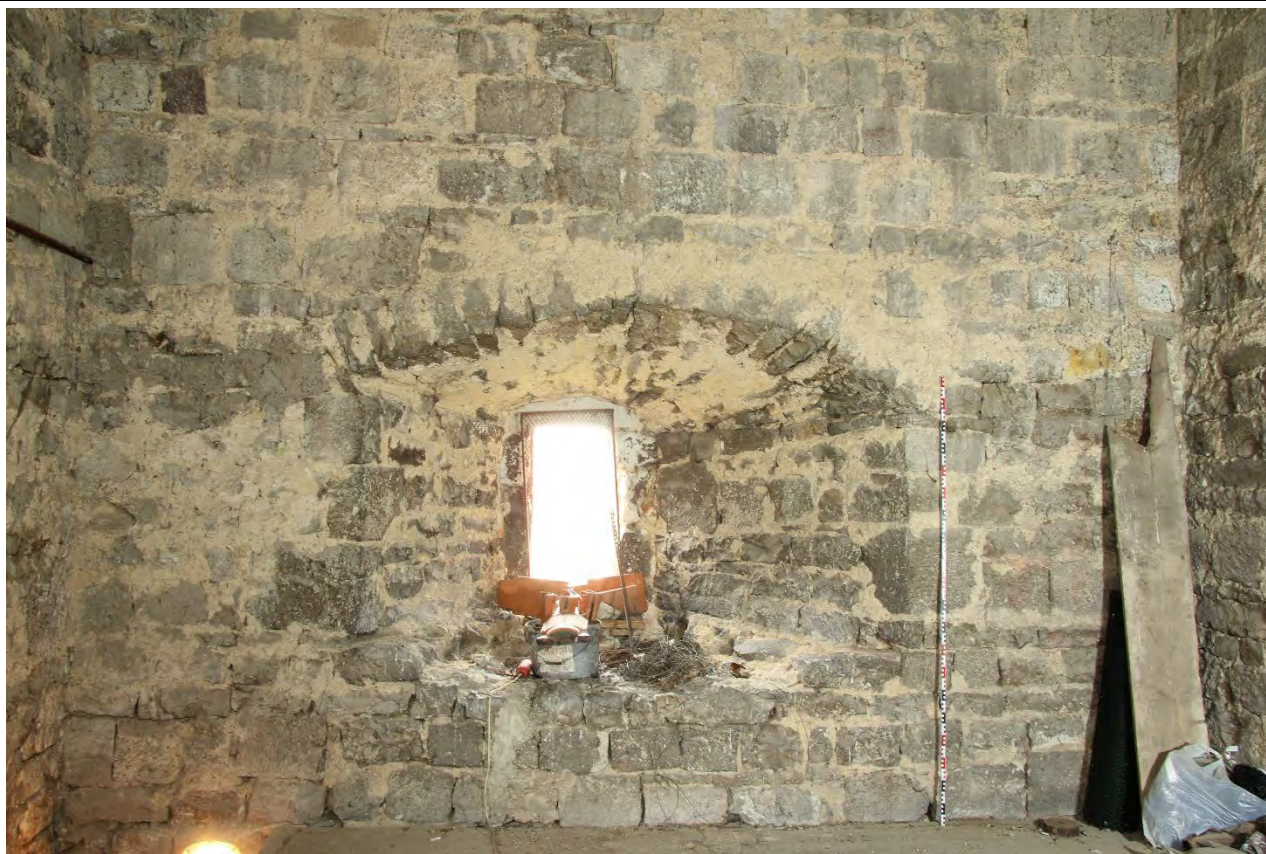
Severní strana druhého patra věže v pohledu od jihu. Foto: Jaroslav Skopec, 2019.
