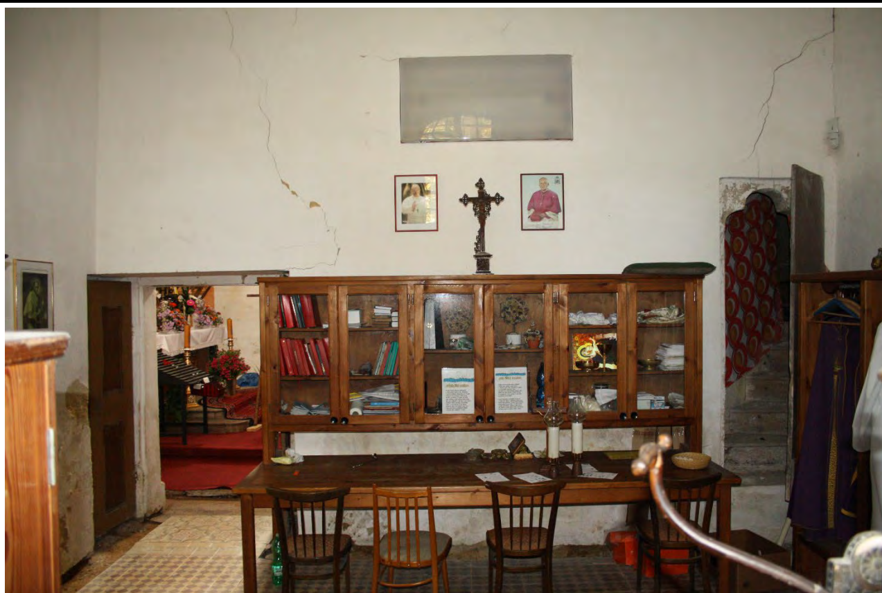
Západní strana sakristie v pohledu od východu. Foto: Marta Pavlíková, 2021.
