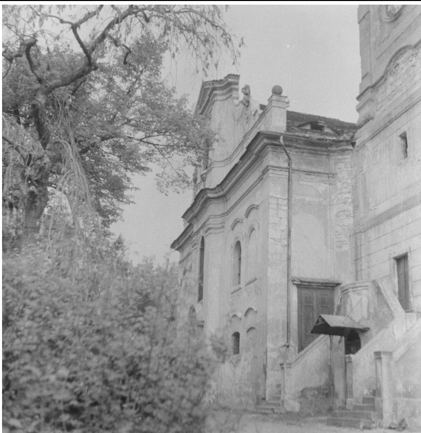
Severní průčelí lodi v pohledu od severozápadu. Foto: 1963, sbírka negativů NPÚ ÚOP v Ústí n. L., sign. 8797.
