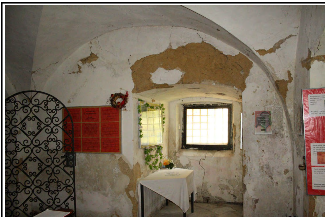
Severní strana přízemí věže v pohledu od jihu. Foto: Marta Pavlíková, 2021.
