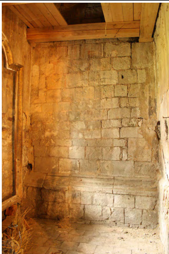
Čelní pohled na východní konec jižní zdi věže v pohledu z bývalé márníce. Foto: Jaroslav Skopec, 2014.
