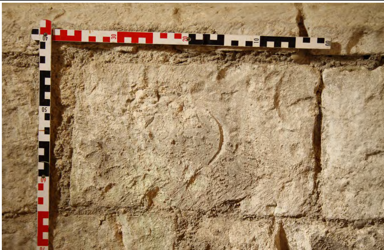
Detail kamenické značky ve tvaru obráceného písmene „C“ na románském kvádru druhotně použitém ve zdivu věže. Foto: Jaroslav Skopec, 2014.
