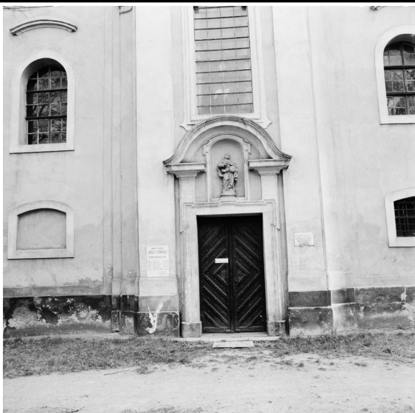
Čelní pohled od severu na hlavní vstup lodi. Foto: 1988, sbírka negativů NPÚ ÚOP v Ústí n. L., sign. 95030.
