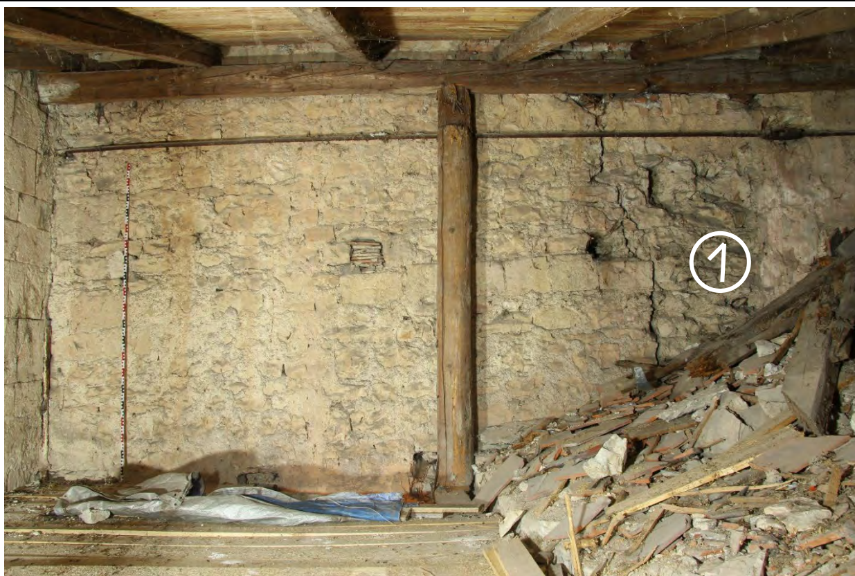
Severní polovina horní úrovně západního zdiva Mariánské kaple v pohledu od západu z prostoru krovu bývalé márnice. Foto: Jaroslav Skopec, 2019. 1) Zřetelný negativ po odstraněném pilíři v ose západního průčelí kaple.
