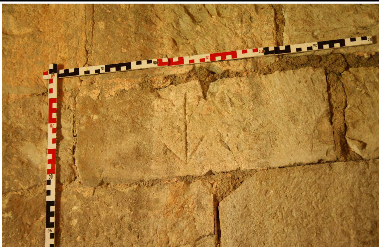
Detail kamenické značky ve tvaru šipky na románském kvádru druhotně použitém ve zdivu věže. Foto: Jaroslav Skopec, 2014.
