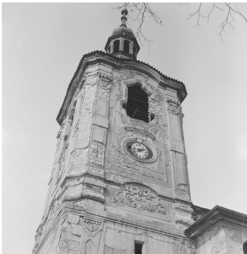
Jižní průčelí horních partií věže v pohledu od jihu. Foto: 1967, sbírka negativů NPÚ ÚOP v Ústí n. L., sign. 27639.
