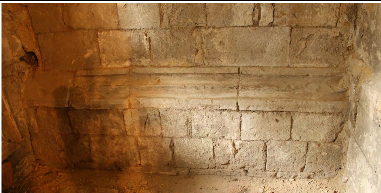
Sokl východního konce jižní zdi věže v pohledu od jihu z prostoru bývalé márníce. Foto: Jaroslav Skopec, 2014.
