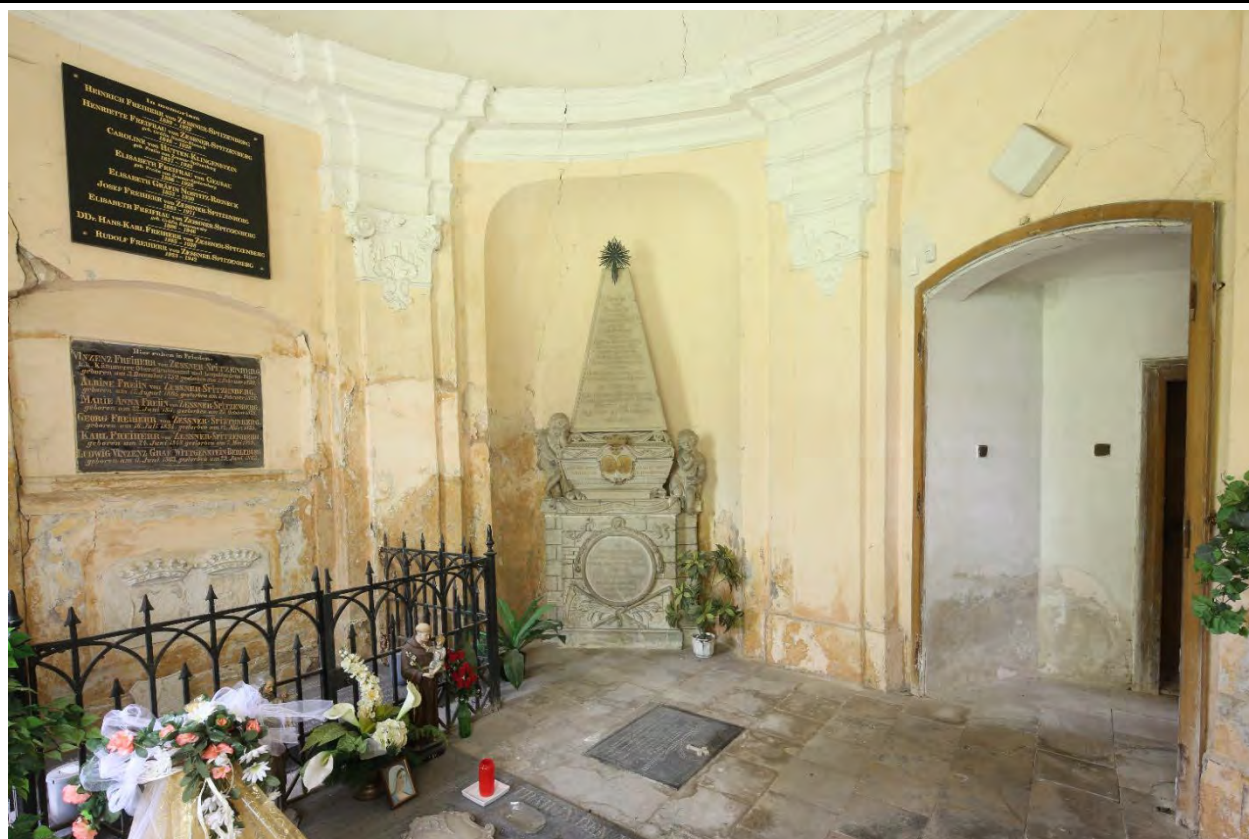
Interiér pohřební kaple v pohledu od jihovýchodu. Foto: Marta Pavlíková, 2021.
